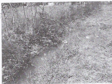
Fig. A2: Canal de agua lluvia
